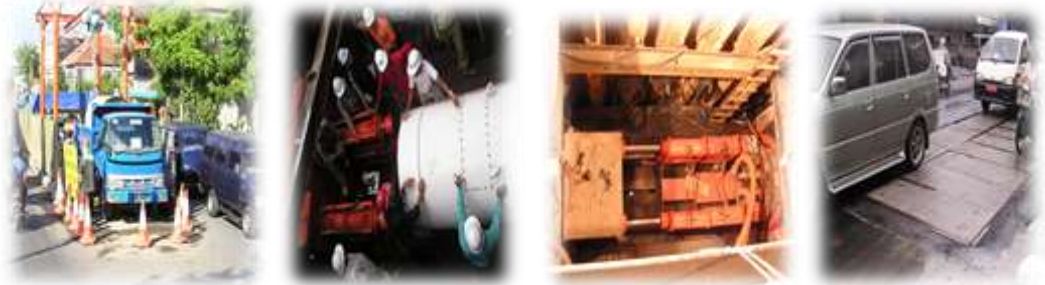
Gambar 2.7 Pelaksanaan Metode “Pipe Jacking”
