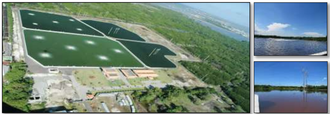
Gambar 2.5 IPAL Suwung, Kolam Aerasi dan Kolam Sedimen
